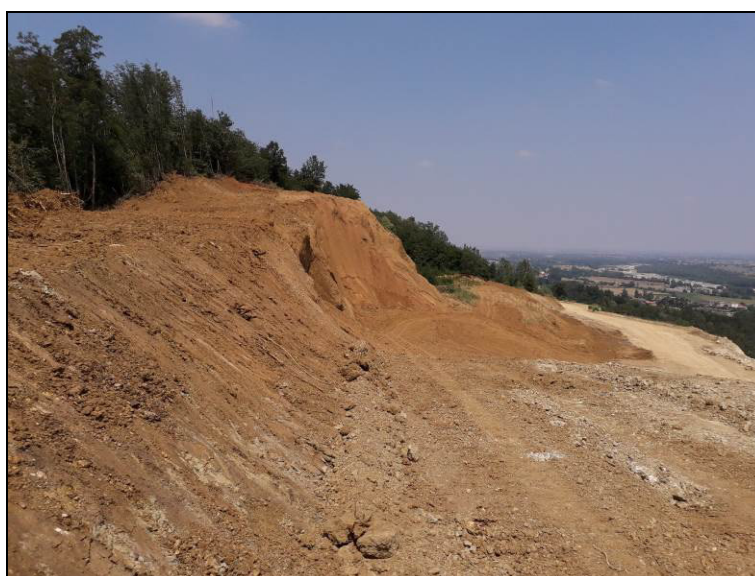
Fotografia 4.3: ripresa laterale dell'orizzonte terroso che ricopre la Formazione della Val Luretta nel cantiere Albarola.
